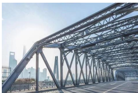
(a) 桁架正面
