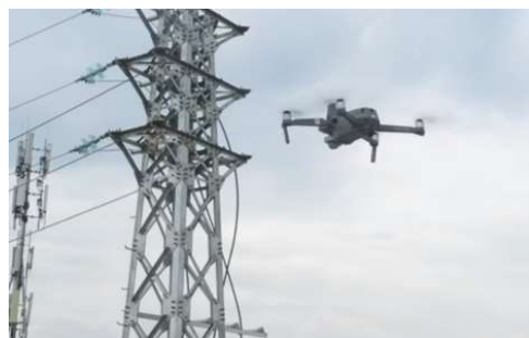
(d) 电力巡检
