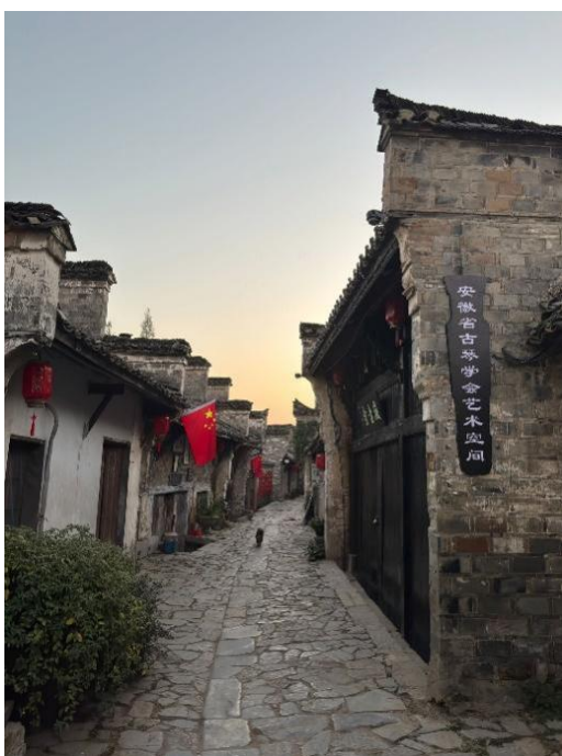
图 4-14 西河古镇徽派建筑
