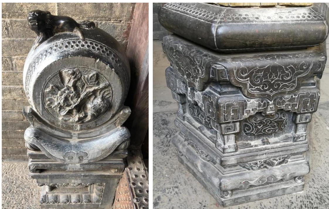
图 3-20 门墩石、柱础
