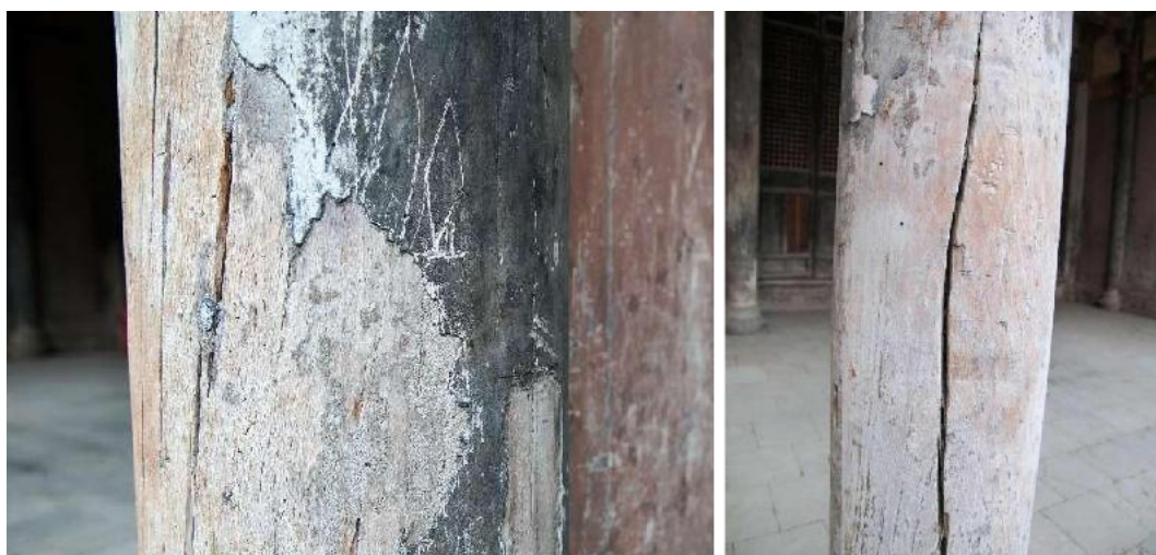
图 3-33 立柱受损图
