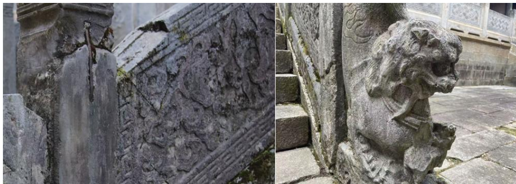
图 3-35 石雕破损图
