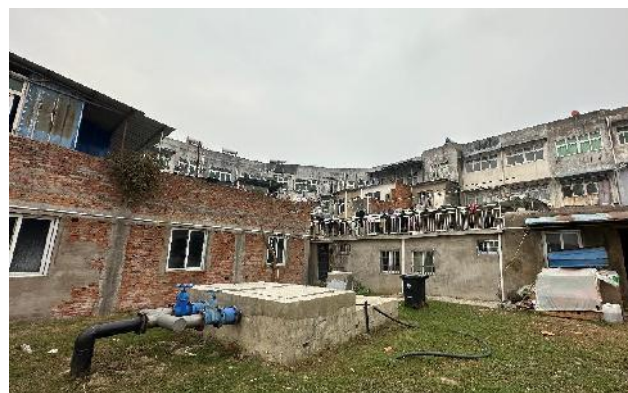
公共设施裸露在外
