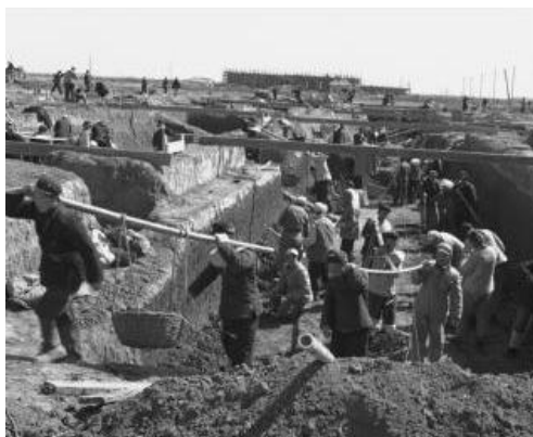
图 2-1 第一拖拉机厂开挖地基
