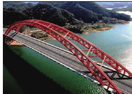
(e) 安徽太平湖大桥
