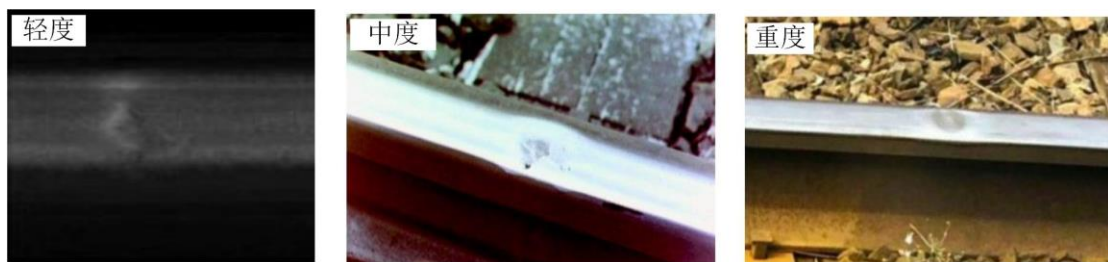
图 3-1 钢轨表面的凹坑不平顺 [87]
