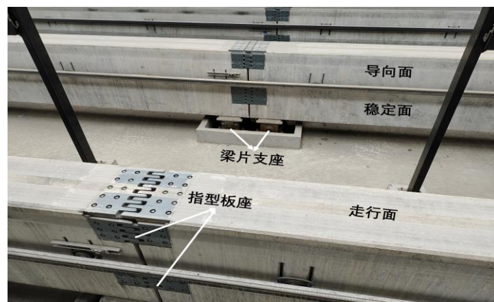
图 2-1 PC 轨道梁结构
