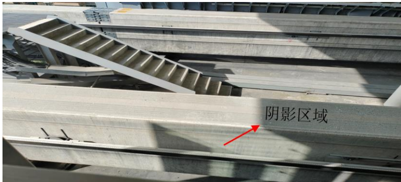
图 1-4 轨道梁面光照不均匀
