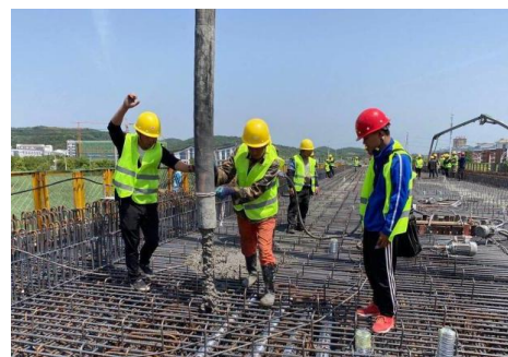
图 1-4 末端灌浆软管人力拖动方式
