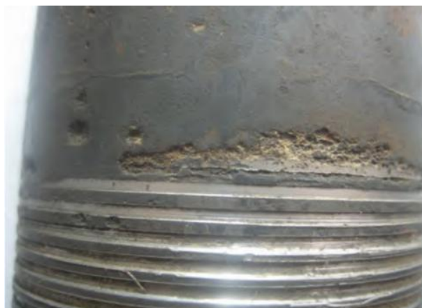
图 1-2 管外壁腐蚀状况 [18]
