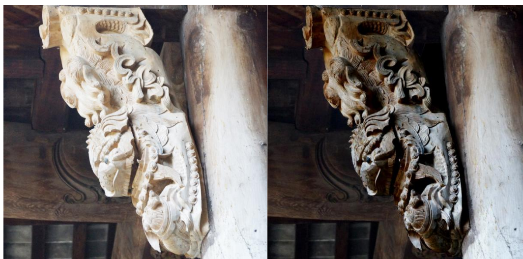
如图 5-4 狮子纹撑拱修复图（图片来源：作者自摄）
