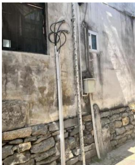
图 4-15 电线外漏
