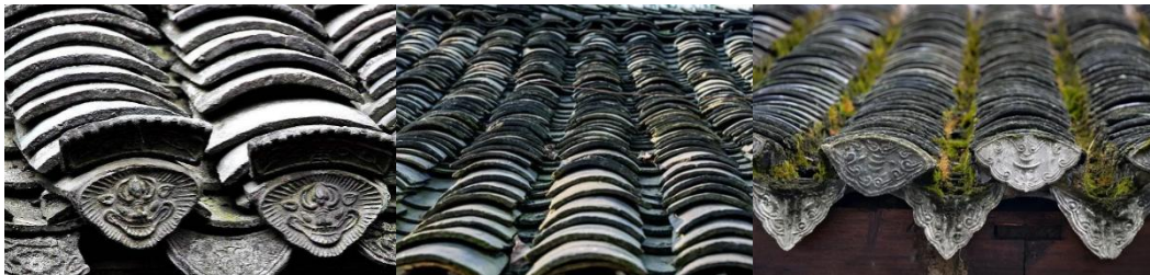
图 4-11 徽州建筑屋面
