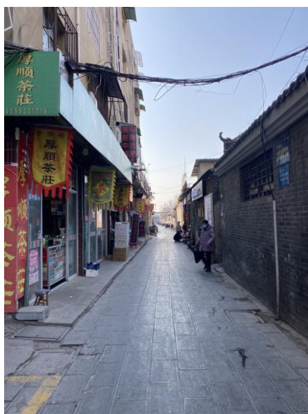
图 4-1 基础设施缺失
